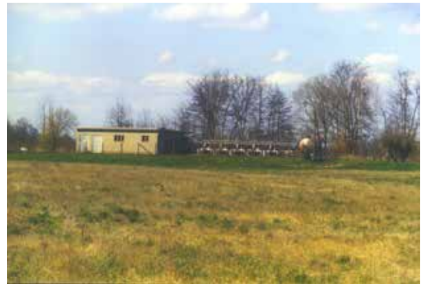
Das ehemalige Deetzer Brauchwasserwerk vor dem Abriss
