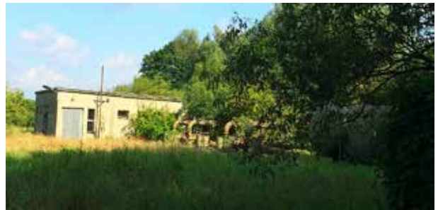
Stillgelegtes Brauchwasserwerk bei Schmergow
