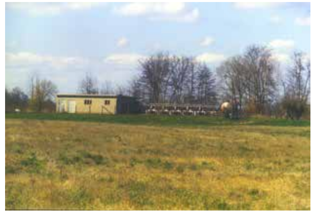
Das ehemalige Deetzer Brauchwasserwerk vor dem Abriss
