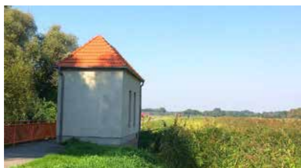
Schöpfwerk bei Deetz
