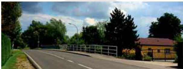
Die neue Brücke
