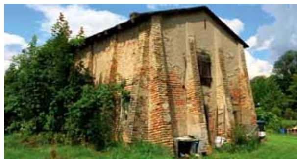
Ehemal. Kohlenschuppen der Ziegelei Jöllennebeck
