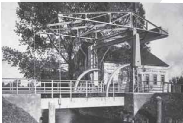
Die eiserne Zugbrücke
